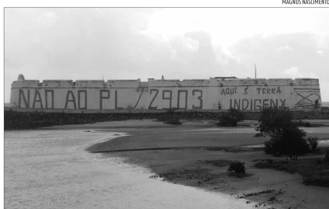
Para pintura da fachada, foi necessária uma autorização do Iphan, por ser prédio tombado
